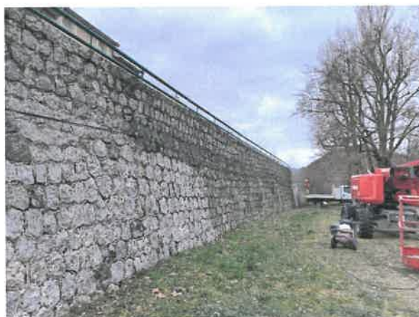
Mars 2024 : étape de dévégétalisation et de préparation du parement au rejointement
